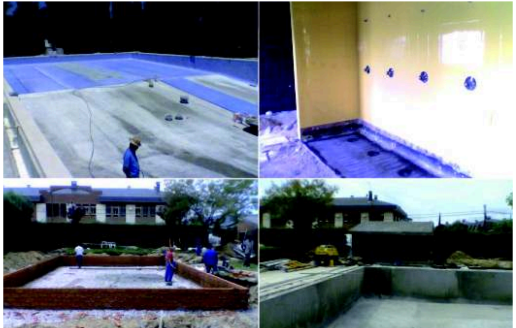
Imágenes retrospectivas de las obras de construcción de 2005 gobernando PSOE.
